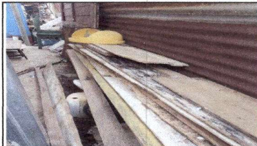
FOTO 8: Reparación de tubo hg y malla galvanizada
