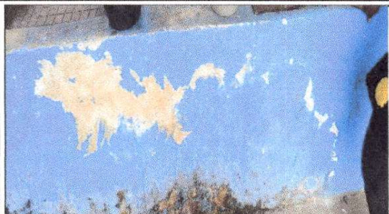
FOTO 1: Pintura en muros exteriores e interiores
