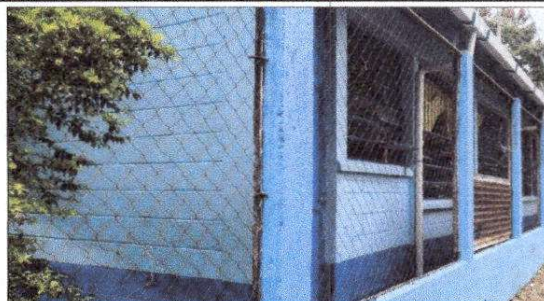
FOTO 2: Pintura en muros exteriores e interiores
