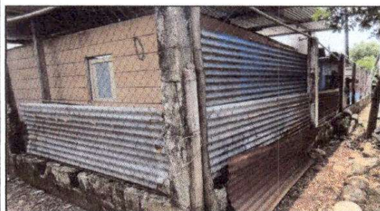
FOTO 3: Reparación de tubo hg y malla galvanizada
