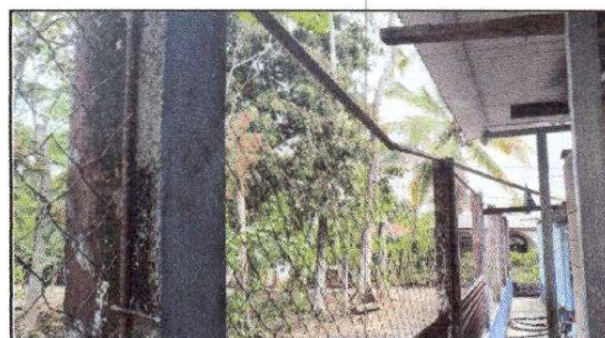
FOTO 4: Reparación de tubo hg y malla galvanizada
